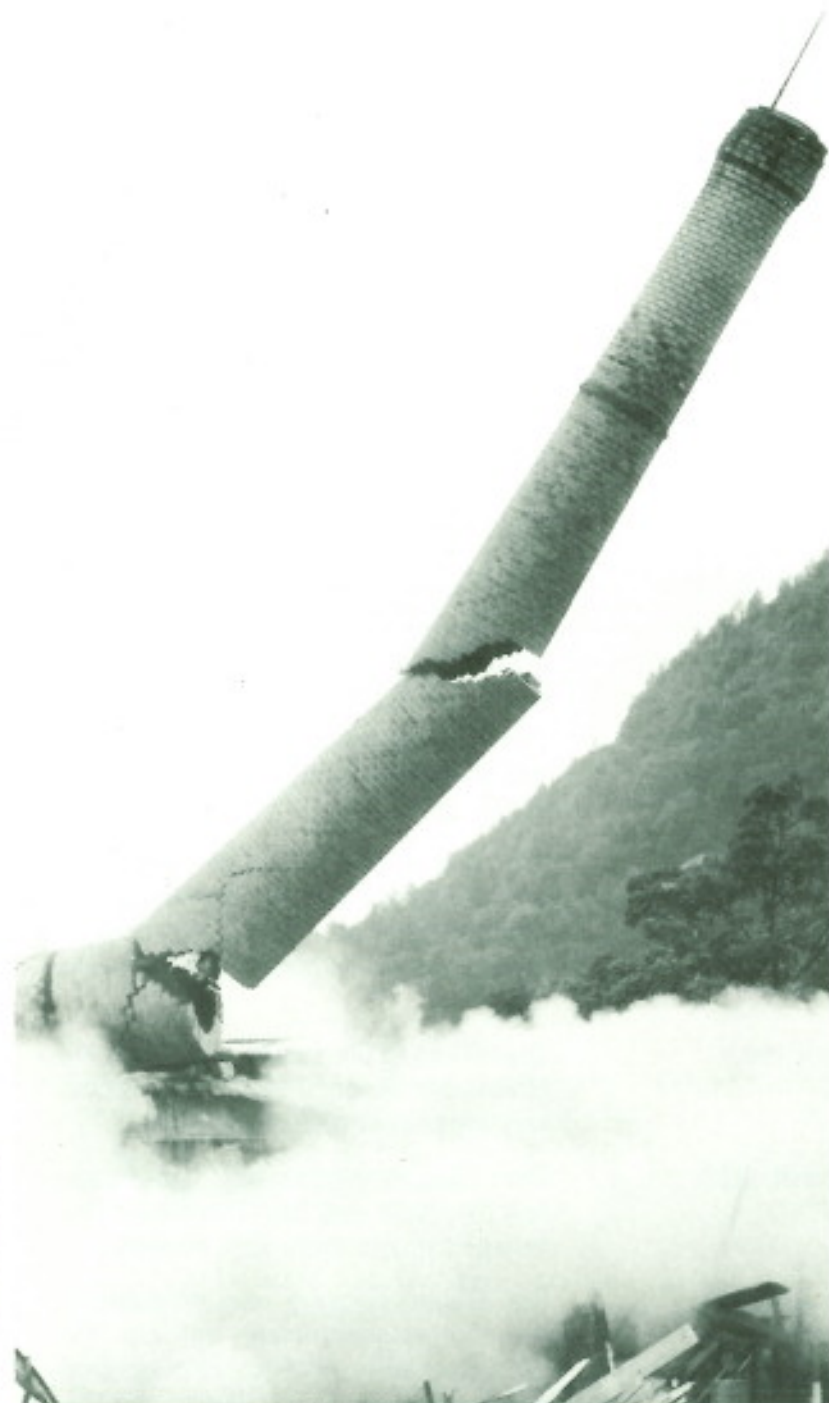
Unaufhaltsam stürzt der Kamin weiter.
