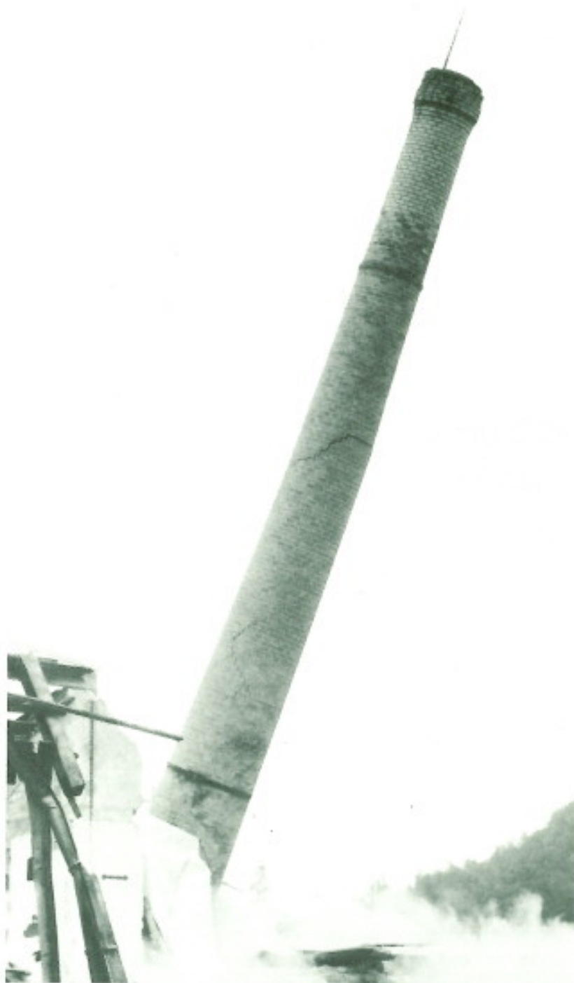
Deutlich sichtbar, wie er in der Mitte bricht.
